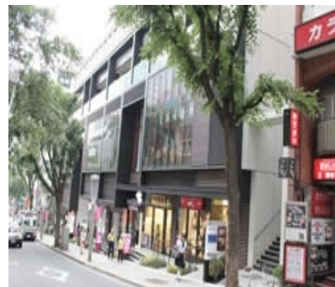
PORTA 神楽坂 ( 森戸記念館側 坂上から見た外観。 坂下寄りに通り抜け箇所アリ )
